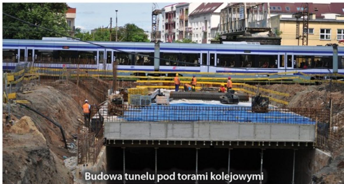
TUNEL DROGOWY pod torami PKP (widok od strony ul. Kilińskiego)
